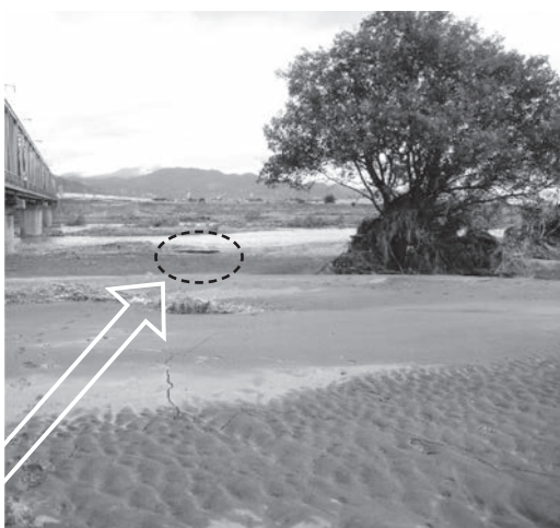
写真2 河川氾濫後 (開渠は土砂で埋没。河川にも土砂が堆積している。点線で囲まれたところが放流配管の先端)
